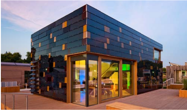
In ein Haus integrierte, von Würth Solar hergestellte CIGS-Module
